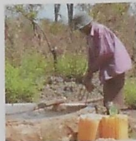
2014: Installation einer Wasserpumpe und Wassersystem im Land. Angetrieben mit Generator.
