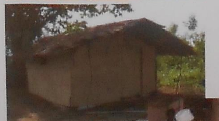
Diese arme Witfrau mit 2 Kindern erhielt ein neues Haus. Beachboys halfen beim Bau mit.
